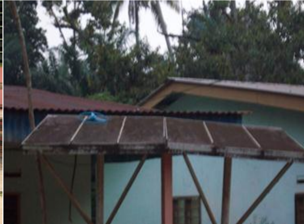
Gambar: Modul PV yang tidak dijaga dengan baik.
