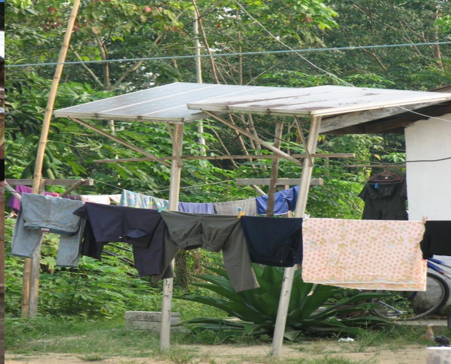
Gambar: Sengaraan PV yang tidak sempurna.
