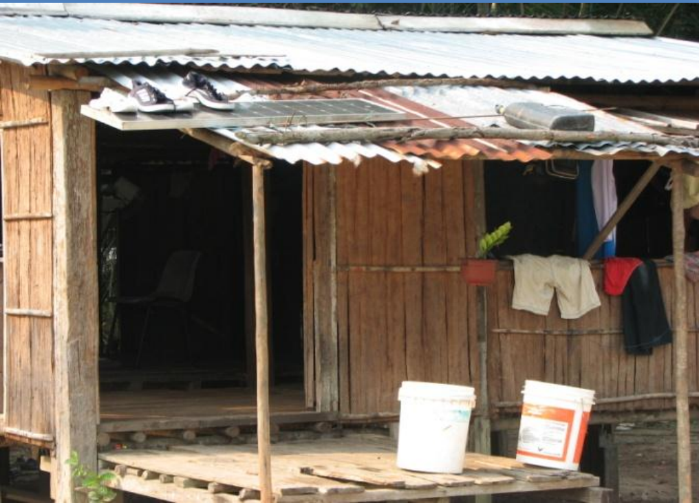
Gambar: Penyalahgunaan modul PV.
